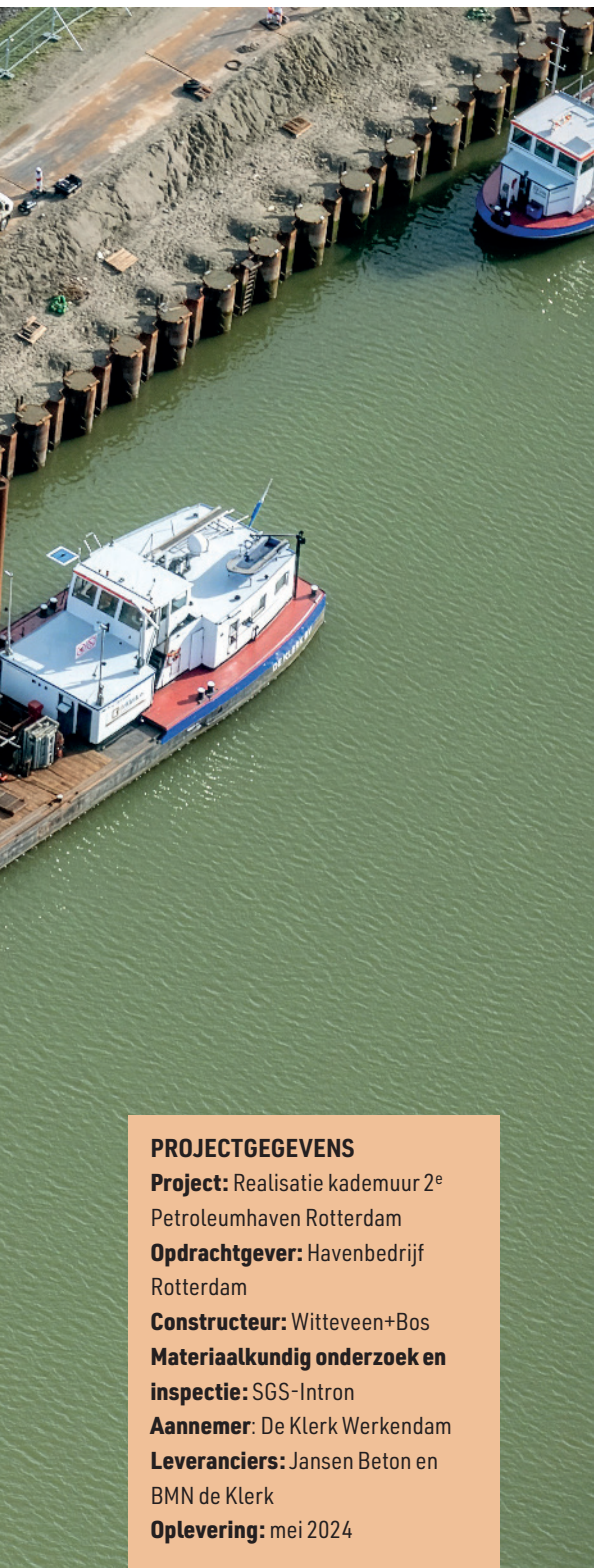
1 Afhangen prefab geopolymeerbeton-elementen (foto: Martens Multimedia)
